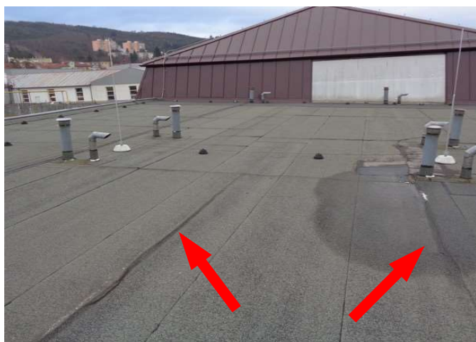
foto/3/ Pohled na vytvořené vrásky hydroizolace a tvořící se kaluže
