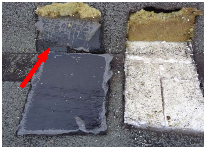
foto/15/ Pohled na provedenou sondu S2 a patrné odtržení asfaltových pásů hydroizolace
