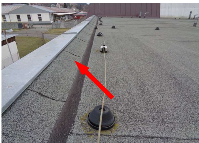
foto/4/ Pohled na odtržení hydroizolace od stěny atiky
