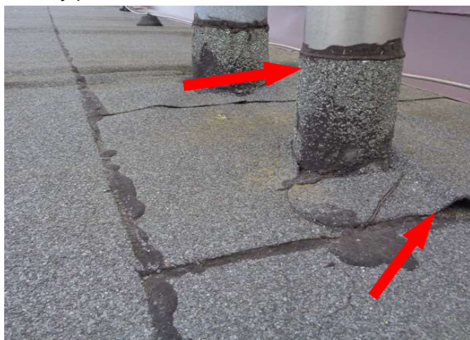
foto/9/ Pohled na opracování kruhového prostupu bez stahovací objímky a netěsnost opracování
