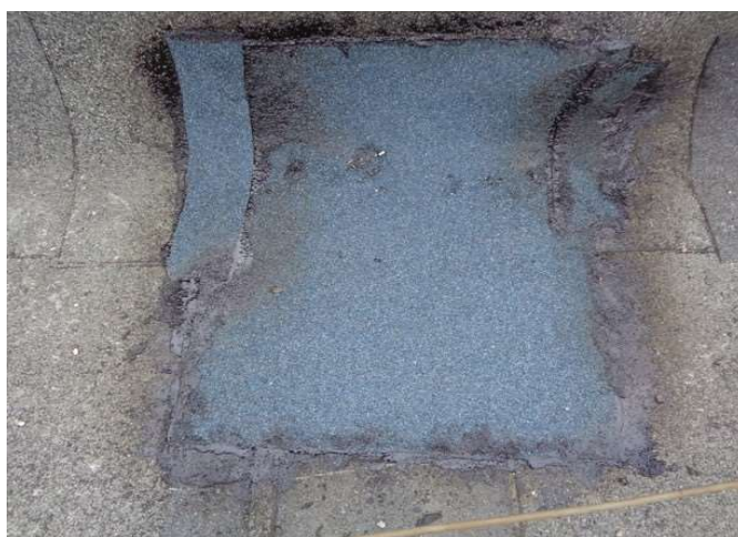
foto/21/ Pohled na zapravenou sondu S3
