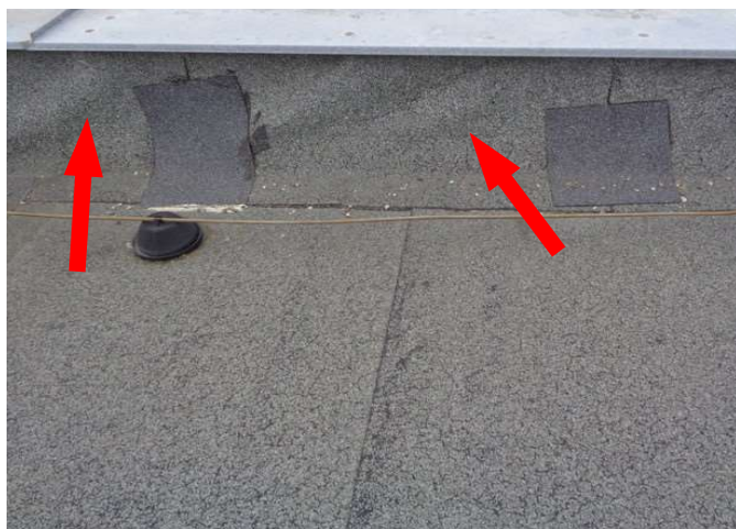
foto/7/ Pohled na vytvořené zvlnění na stěně atiky
