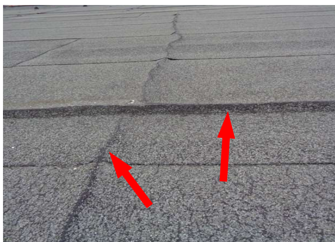
foto/5/ Pohled na vytvořené vrásky hydroizolace
