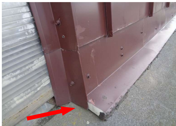
foto/8/ Pohled na netěsné napojení šikmé plechové střechy
