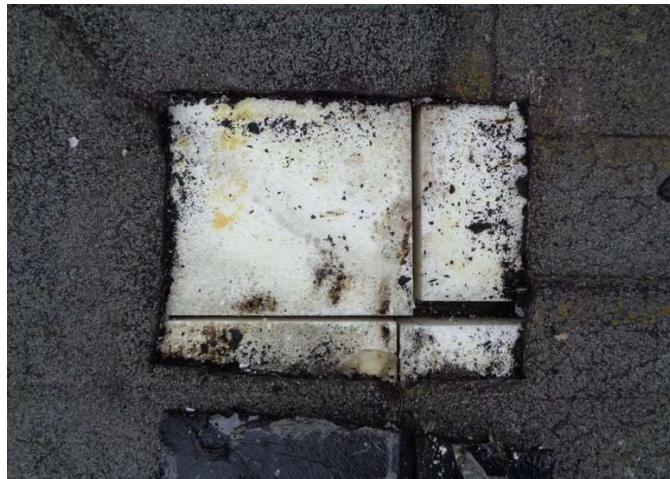
foto/12/ Pohled na mezery mezi tepelně izolačními deskami sondy S1
