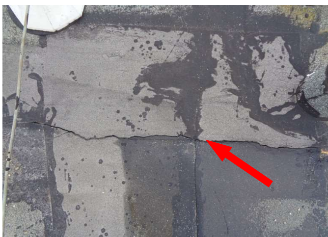
foto/6/ Pohled na praskliny hydroizolace
