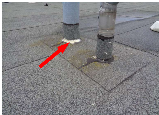
foto/10/ Pohled na opracování kruhového prostupu dodatečným zatmelením
