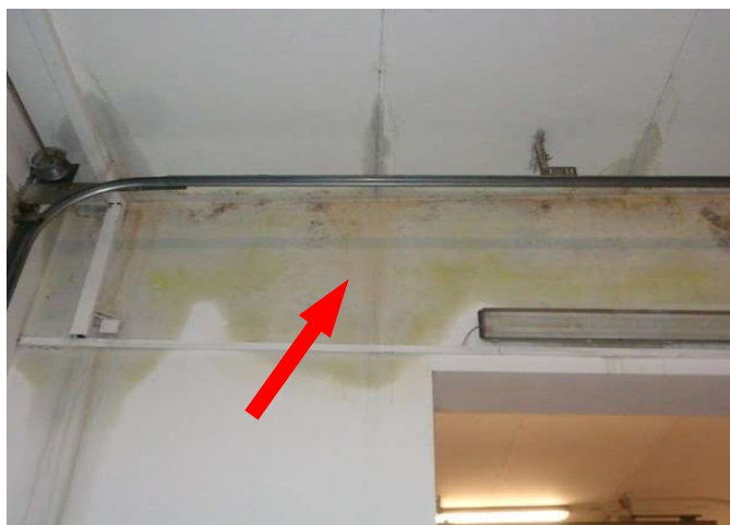
foto/1/ Pohled na stopy po zatékání
