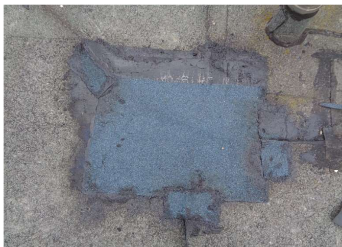
foto/14/ Pohled na zapravenou sondu S1
