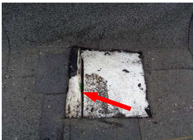
foto/19/ Pohled na provedenou sondu S3 a mezery mezi deskami tepelné izolace
