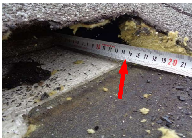
foto/17/ Pohled na provedenou sondu S2 a patrné odtržení asfaltových pásů hydroizolace od atiky
